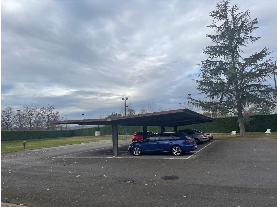
Vista del parking del CSM Albelda de Iregua.
